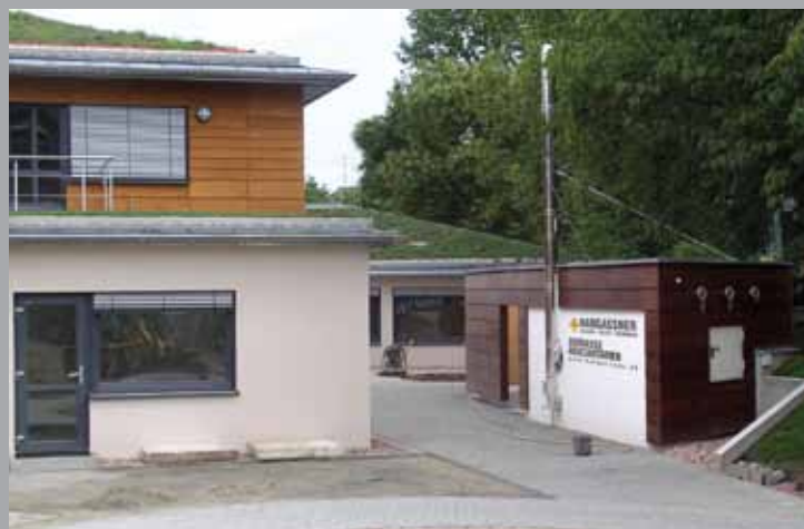
Enkelvoudige pelletscontainer met houten bekleding en groene dakbekleding
