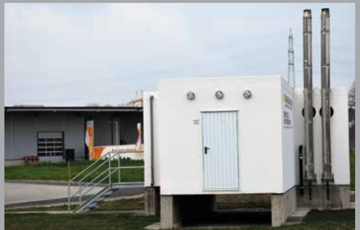
Twee enkellagige pelletscontainers voor verwarmings- en pelletopslagruimte van een bedrijf.
