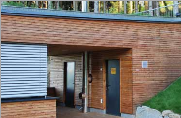
Enkelvoudige pelletscontainer met houten bekleding geïntegreerd in de lokalen van een sportclub.
