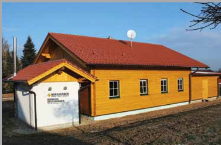
Enkelvoudige pelletscontainer met dakstoel naast woonhuis.
